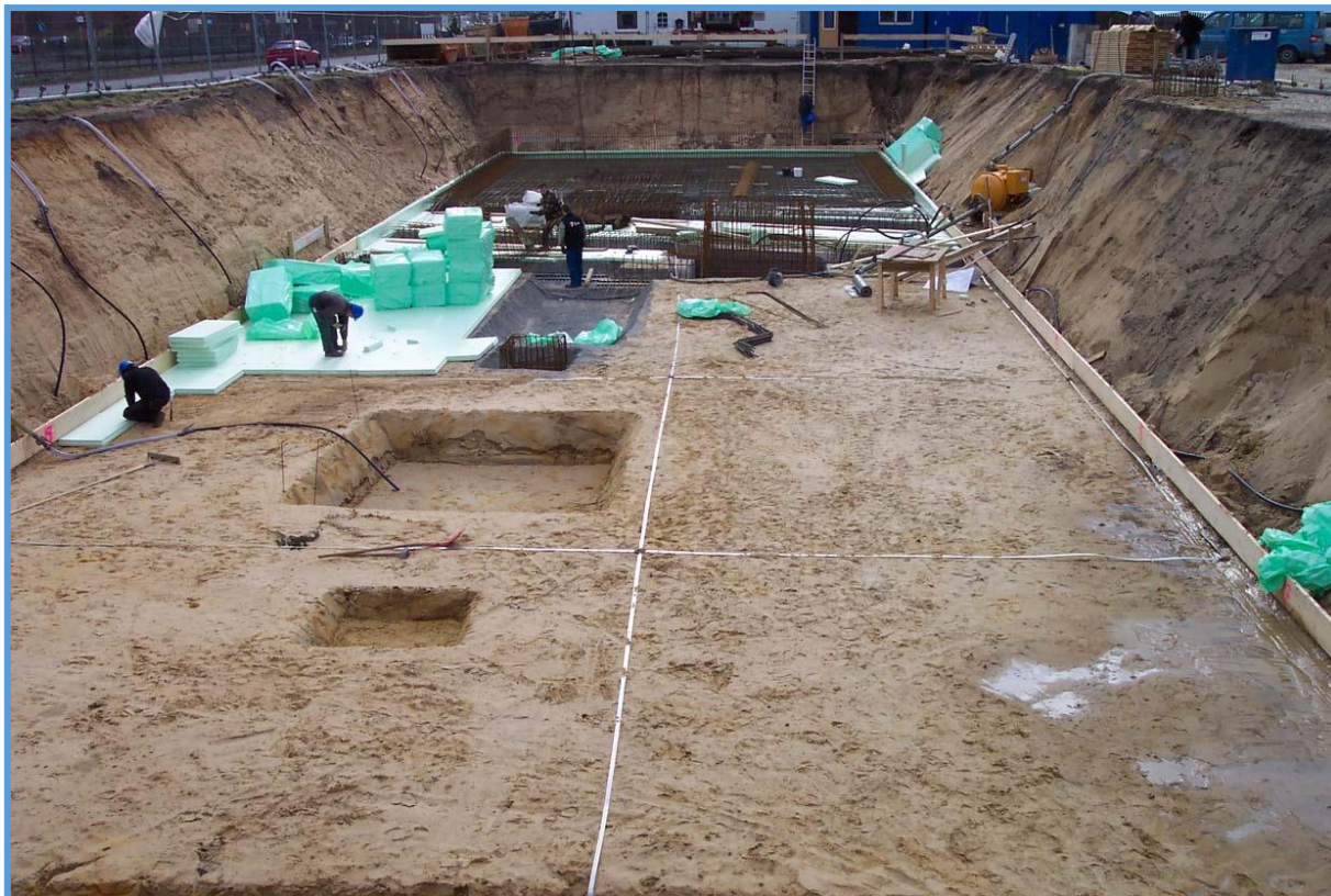
10. ábra, Teljes kerületi szigetelés esetén a betonlap alá helyezett keretföldelőt rozsdamentes acélból kell készíteni
